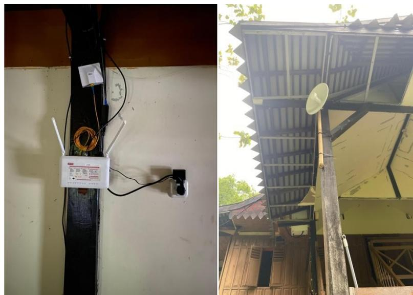
Gambar 6. Hasil pemasangan Router dan Antena Ubiquiti
