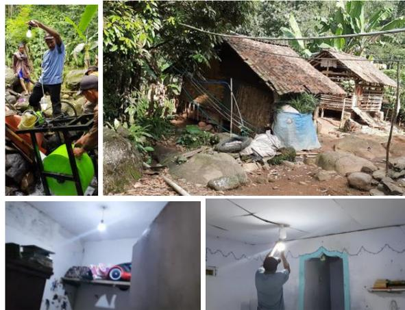
Gambar 7. Pemasangan perangkat mikrohidro *portable* di sungai dan instalasi saluran listrik ke rumah warga Dusun Rayap, Desa Kemuning Lor
