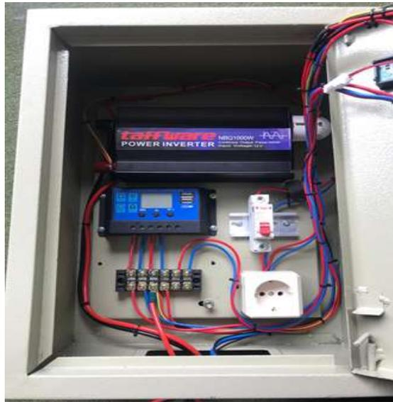
Gambar 3 Komponen PLTS Pada *Box Panel*
