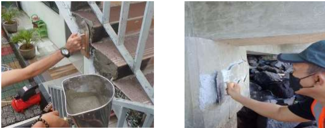
Gambar 5. Pengaplikasian mortar metakaolin geopolimer
