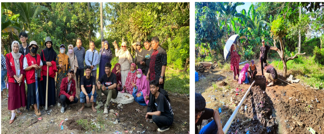
Gambar 3 Mahasiswa dan Dosen melakukan pemasangan pipa dan penutupan penggalian SPALS
