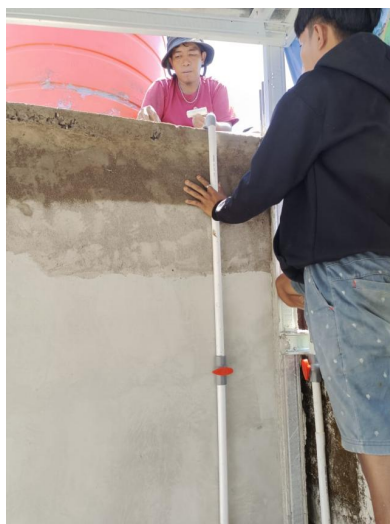
Gambar 4. Proses pembuatan penampungan air
