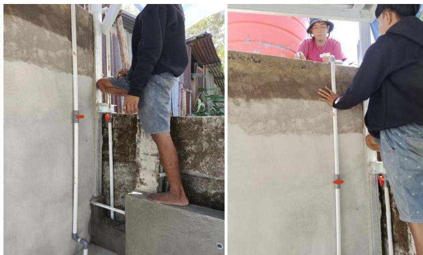
Gambar 4. Kondisi setelah pembuatan instalasi air bersih.
