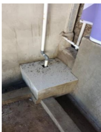
Gambar 4. Kondisi setelah pemasangan pompa air.
