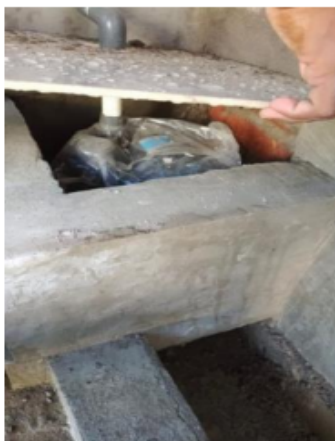
Gambar 3. Proses pemasangan pompa air.
