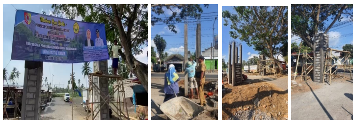
Gambar 8. Proses Pembangunan Gapura Pasar
