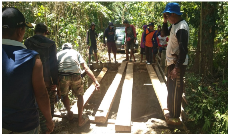
Gambar 4. Pemasangan Balok Girder
