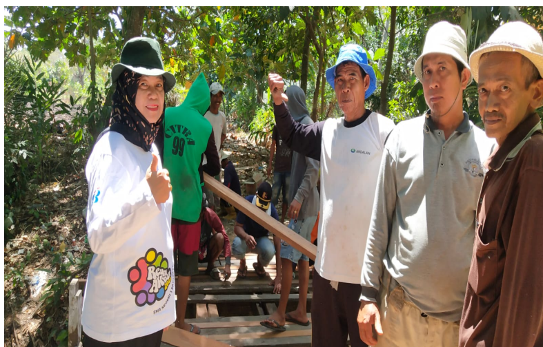
Gambar 5. Pemasangan Papan Lantai Jembatan
