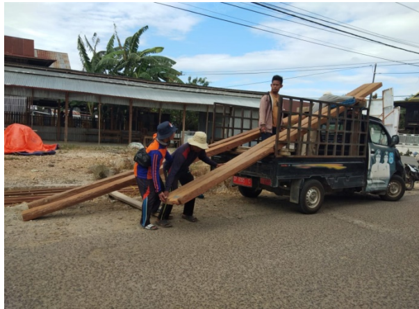
Gambar 1. Pengadaan Balok Girder, Papan Lantai, baut dll
