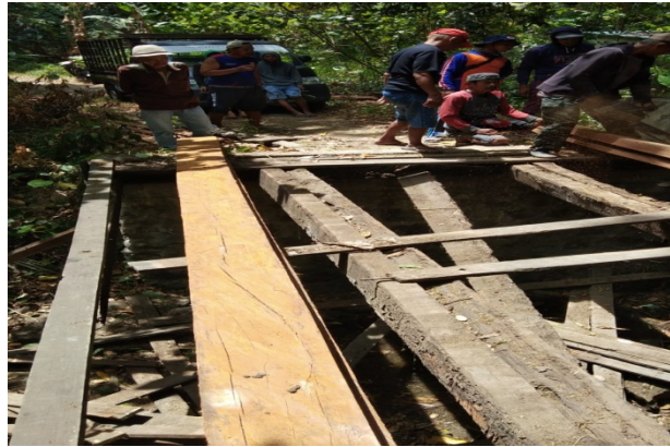
Gambar 2. Pembongkaran Balok dan lantai Papan Jembatan Lama
