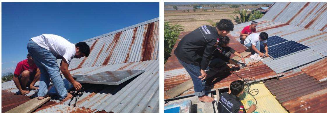
Gambar 5. Pemasangan Panel Surya
