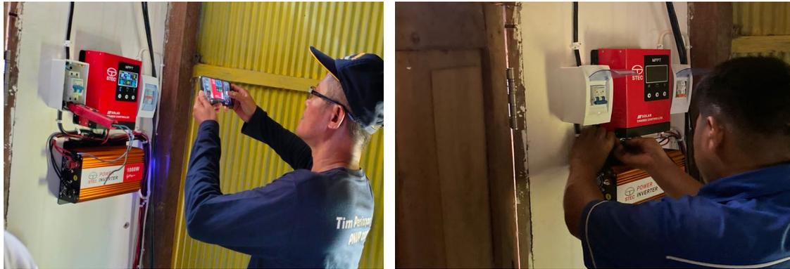
Gambar 6. Pemasangan dan pengukuran rangkaian kontrol panel surya
