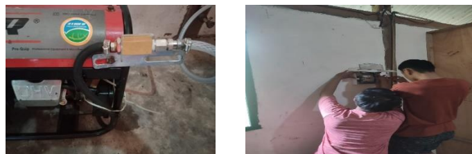
Gambar 3. Pemasangan instalasi listrik
