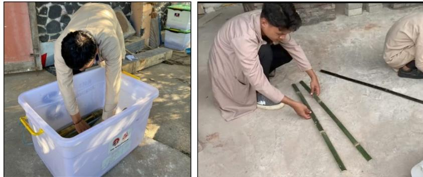
Gambar 3. *Treatment* bilah bambu (perendaman boraks dan pelapisan cat)
