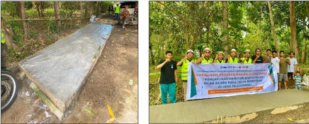
Gambar 7. Jalan pedestrian beton bertulangan bilah bambu
