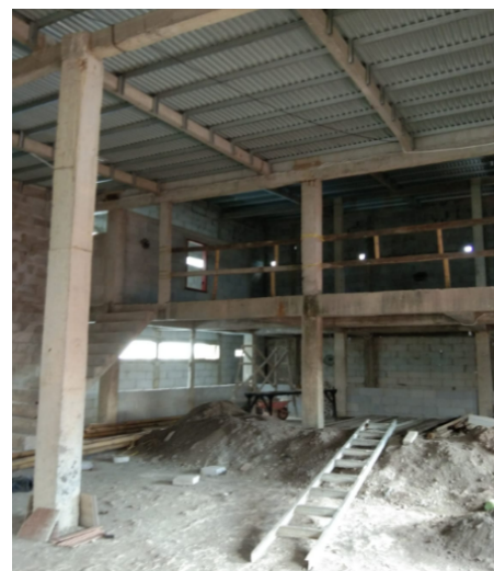
Gambar 3. Kondisi Lantai 2 dan Lantai 3 Masjid /Pondok Uwais Al Qarni
