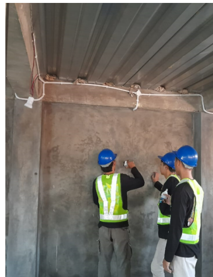
Gambar 7. Pemasangan saklar seri dan Kotak Kontak
