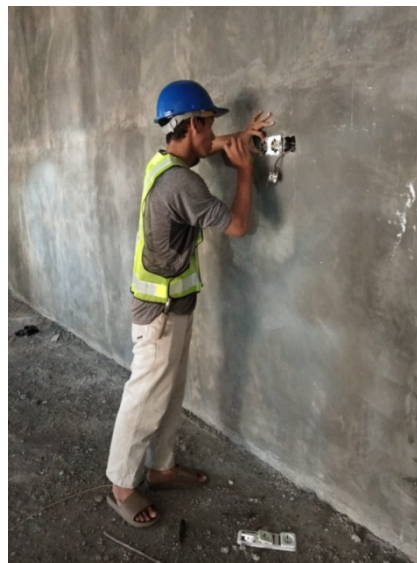
Gambar 7. Pemasangan saklar seri dan Kotak Kontak
