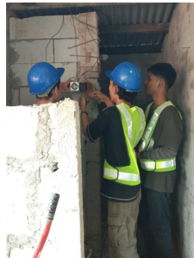
Gambar 6. Pemasangan saklar seri dan saklar tunggal
