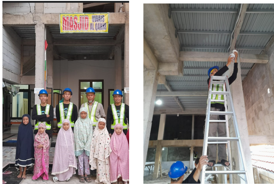
Gambar 8. Pemasangan fitting dan bola lampu
