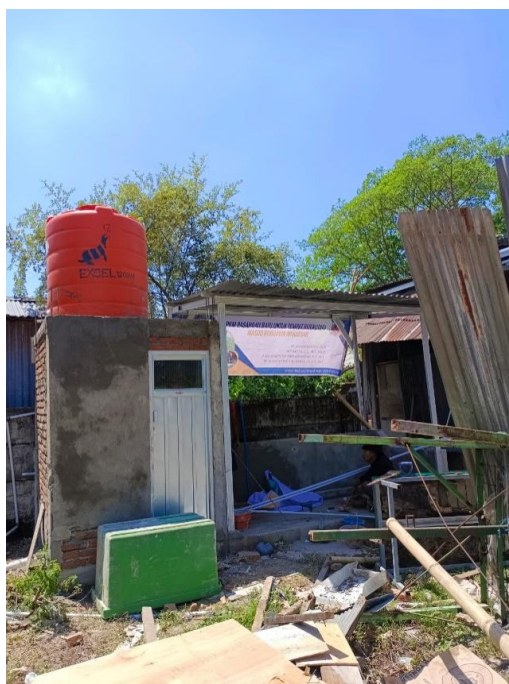
Gambar 5. Kondisi setelah pembuatan penampungan air.
