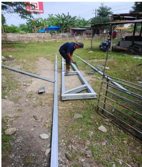
Gambar 3. Proses pembuatan rangka baja.
