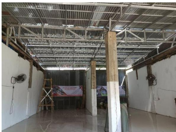
Gambar 4. Kondisi setelah pemasangan atap rangka baja.
