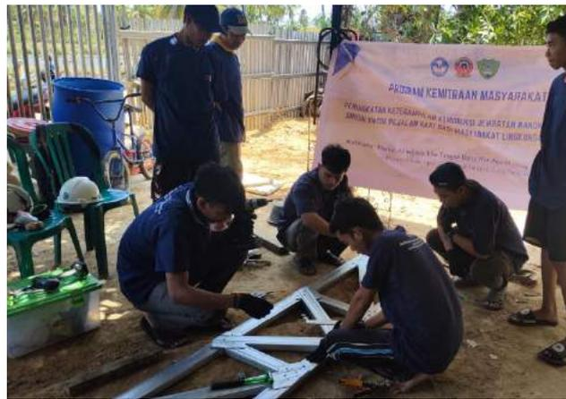
Gambar 10. Merangkai struktur rangka baja ringan.
