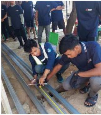
Gambar 7. Memotong profil baja ringan.
