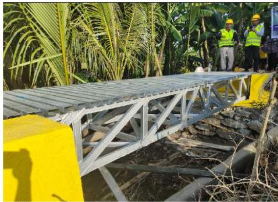
Gambar 2. Aplikasi jembatan baja ringan untuk pejalan kaki di Manjeppu.
