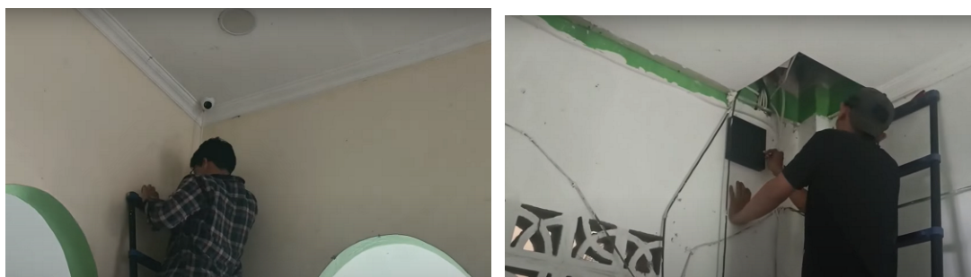
Gambar 5. Pemasangan Kamera CCTV Indoor/Outdoor dan Instalasi Hardware DVR
