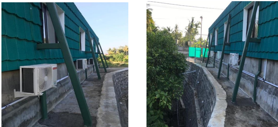
Gambar 4. Hasil pekerjaan elemen pengaku pada Bangunan Klinik
