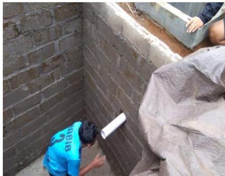
Gambar 6. Pemasangan Pipa Penyalur
