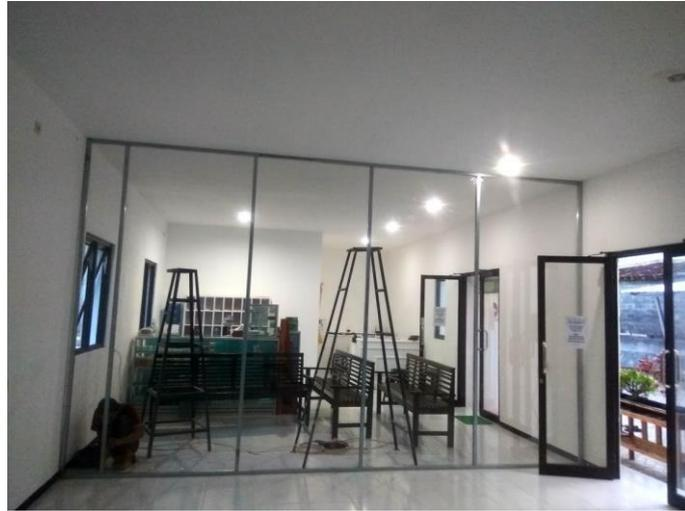
Gambar 4 Proses perakitan dan *erection* partisi ruang isolasi
