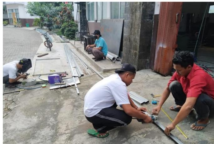
Gambar 3 Proses pembuatan partisi ruang isolasi
