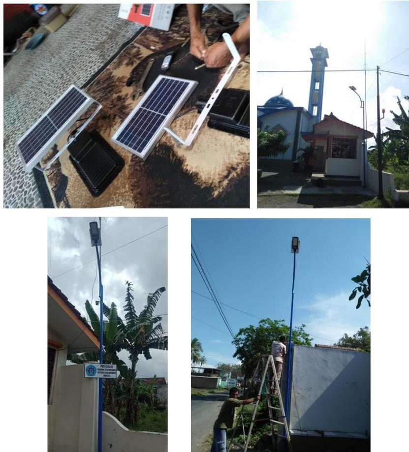
Gambar 3. Pemasangan Panel Surya
