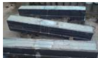
Gambar 3 Balok setelah di cor
